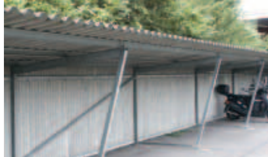
Façades, toits en amiante-ciment garages à vélos, façades de bâtiments, etc.
